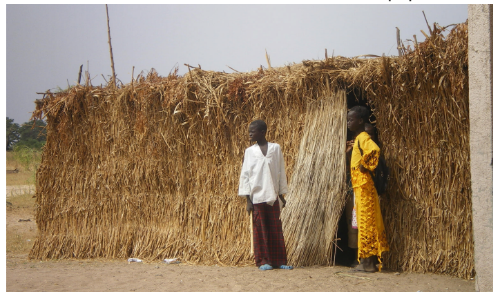
Un local de fortune en branchages, adossé à une classe "EBS", en attendant d'autres constructions "en dur"
